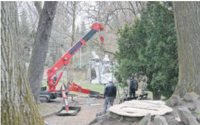
Im Schlosspark ist im März 2023 ein Kran aufgebaut, um die 600 Kilogramm schwere Figur wieder auf den Sockel zu heben.
