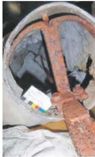
Blick ins Innere II: korrodierte Stützkonstruktion
